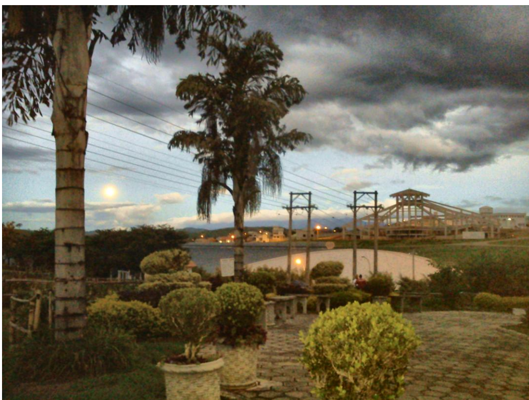
Vista da construção do Santuário Pai das Misericórdias na sede da Canção Nova.
